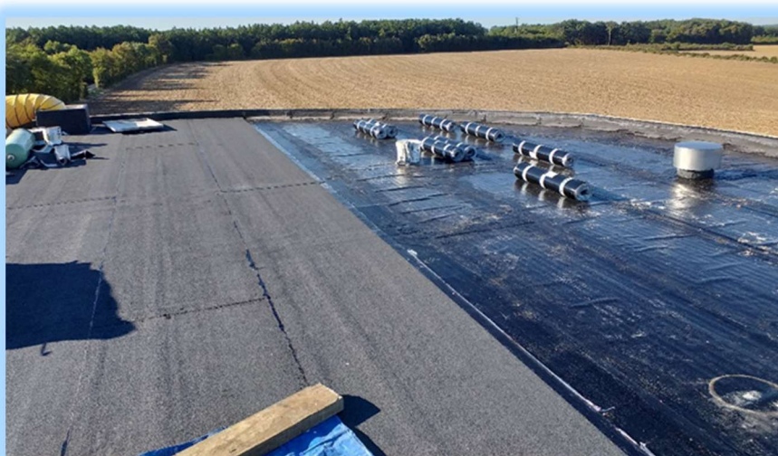
Reprise de l'étanchéité de la cuve n°1 de la Bataille - Chef Boutonne -
