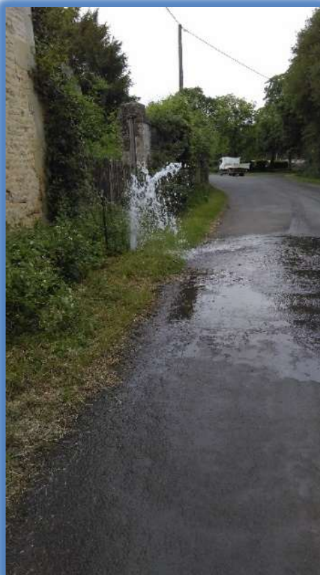
Réalisation d'une purge sur le réseau
