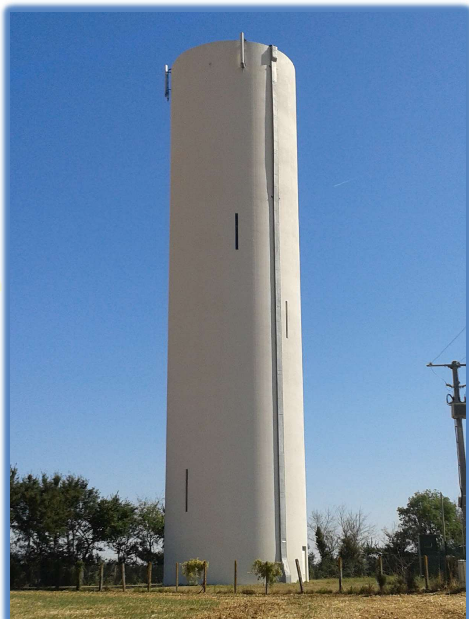
Le château d'eau de la Boucharderie à Périgné
